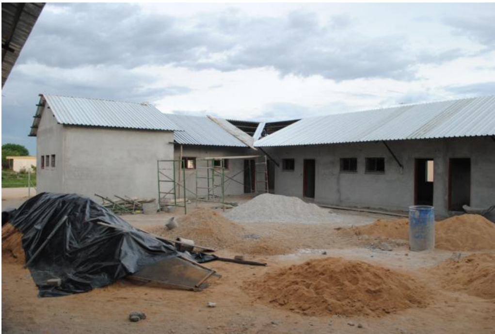
Die neue Vorschule mit fast fertigem Dach
