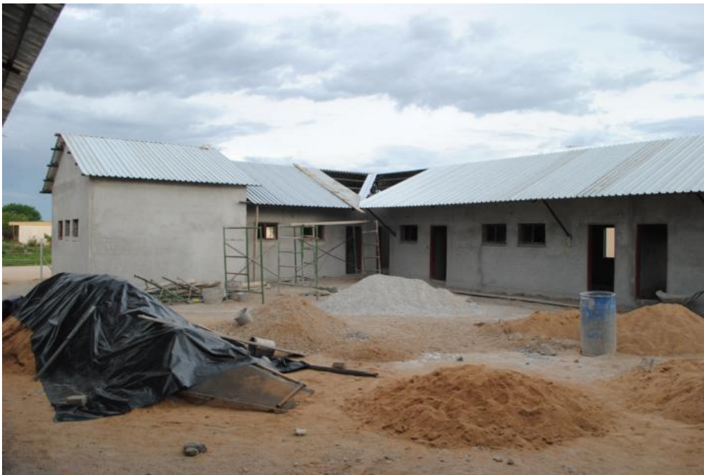
Die neue Vorschule mit fast fertigem Dach
