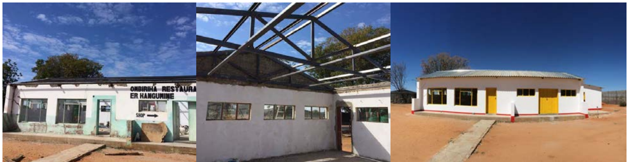
Fotos: Die Gebäude in Ongombombonde vor, während und nach dem Umbau
